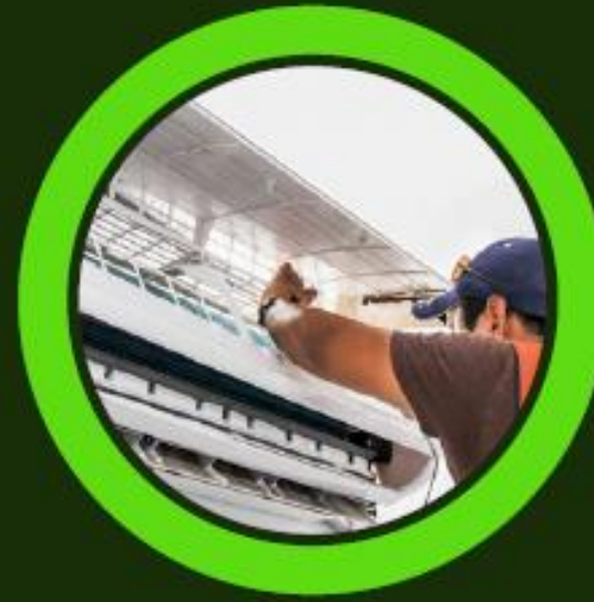
PERKHIDMATAN PENYELENGGARAAN PENGHAWA DINGGIN
